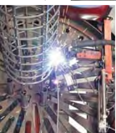
Machine à souder les armatures de pieux de fondation.
