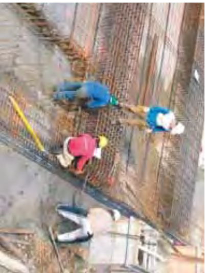
Pose d'armature sur chantier.
