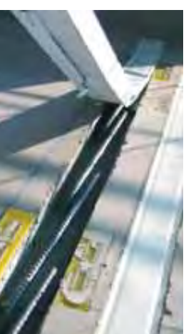
Boîte d'attente à support amovible. Dégagement des armatures.
