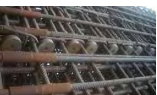
Rabouillages et ancrages.
